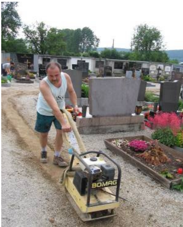
Die erste Leitung ist verlegt und wird von Hr. Szasz mit maschineller Hilfe verdichtet.
